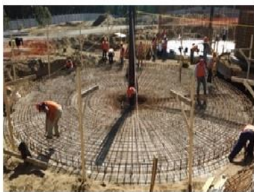
Enfierradura Losa inferior Sedimentador N° 1.
