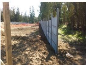
Instalación de placas cerco perimetral del Recinto PTAS
