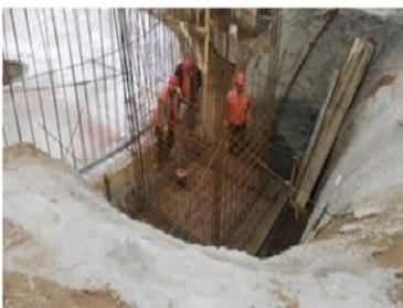
Enfierradura vertical planta elevadora N° 2, R.A.S.
