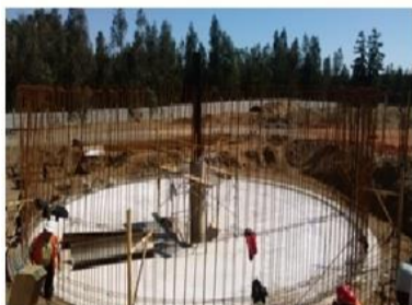
Descimbre tubería central sedimentador N° 2.
