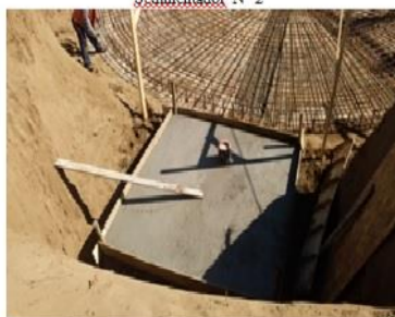
Construcción de emplantillado y trazado en Plantas Elevadoras N° 1 y 2, RAS.
