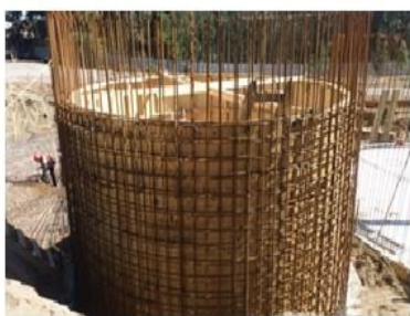
Enfierradura y moldaje interior en Digestor.
