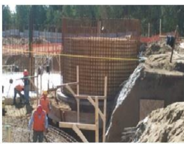
Enfierradura y moldaje interior en Digestor.
