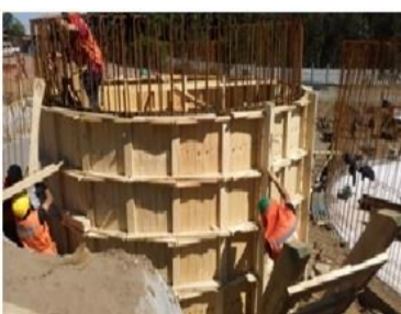
Instalación moldaje exterior en Digestor.
