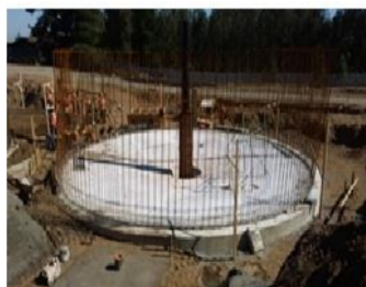
Instalación de Moldaje en tubería central de Sedimentador N° 2
