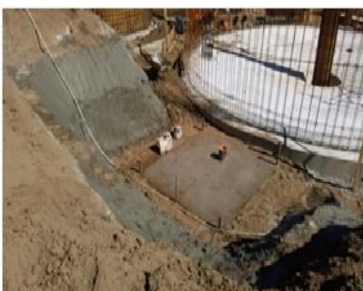
Construcción de emplantillado y trazado en Plantas Elevadoras N° 1 y 2, RAS.
